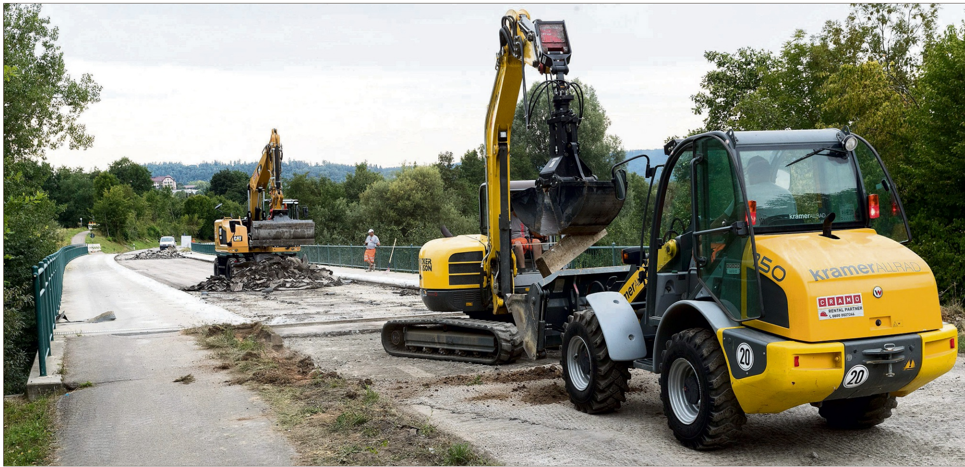
Derzeit sind die Arbeiter damit beschäftigt, den Fahrbahnbelag der Murrbrücke zu entfernen.
